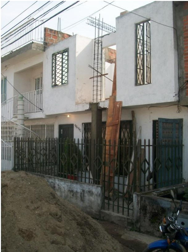
La construction de la salle commune a commencé
